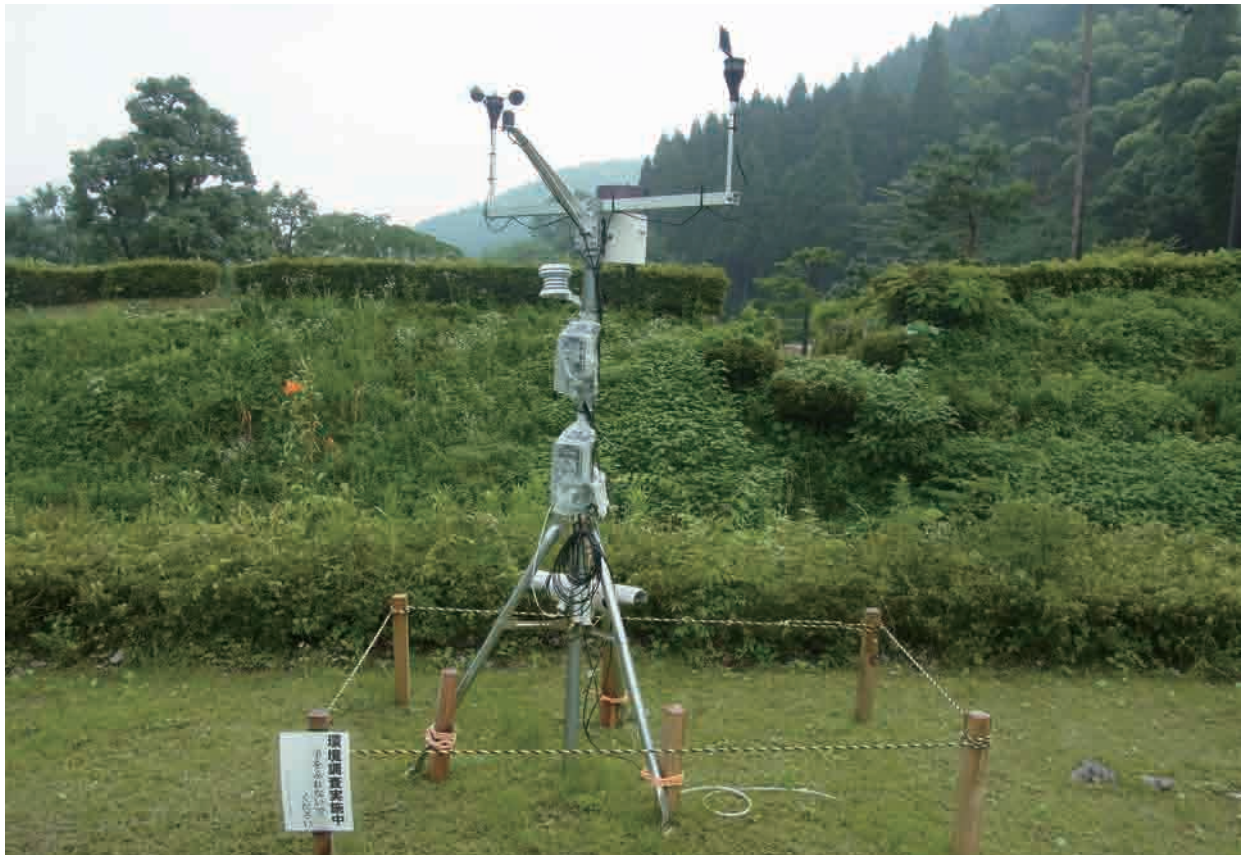
St. 1 ロガーおよびセンサー設置状況
