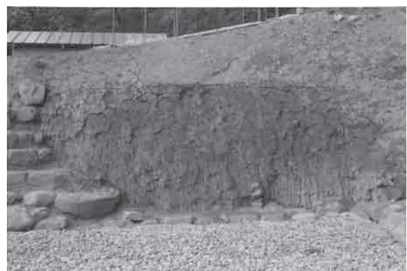
第9図 土製遺構の保存科学的処理 (上：処理中、下：処理後)
