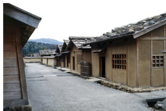
復原町並（立体復原地区）
